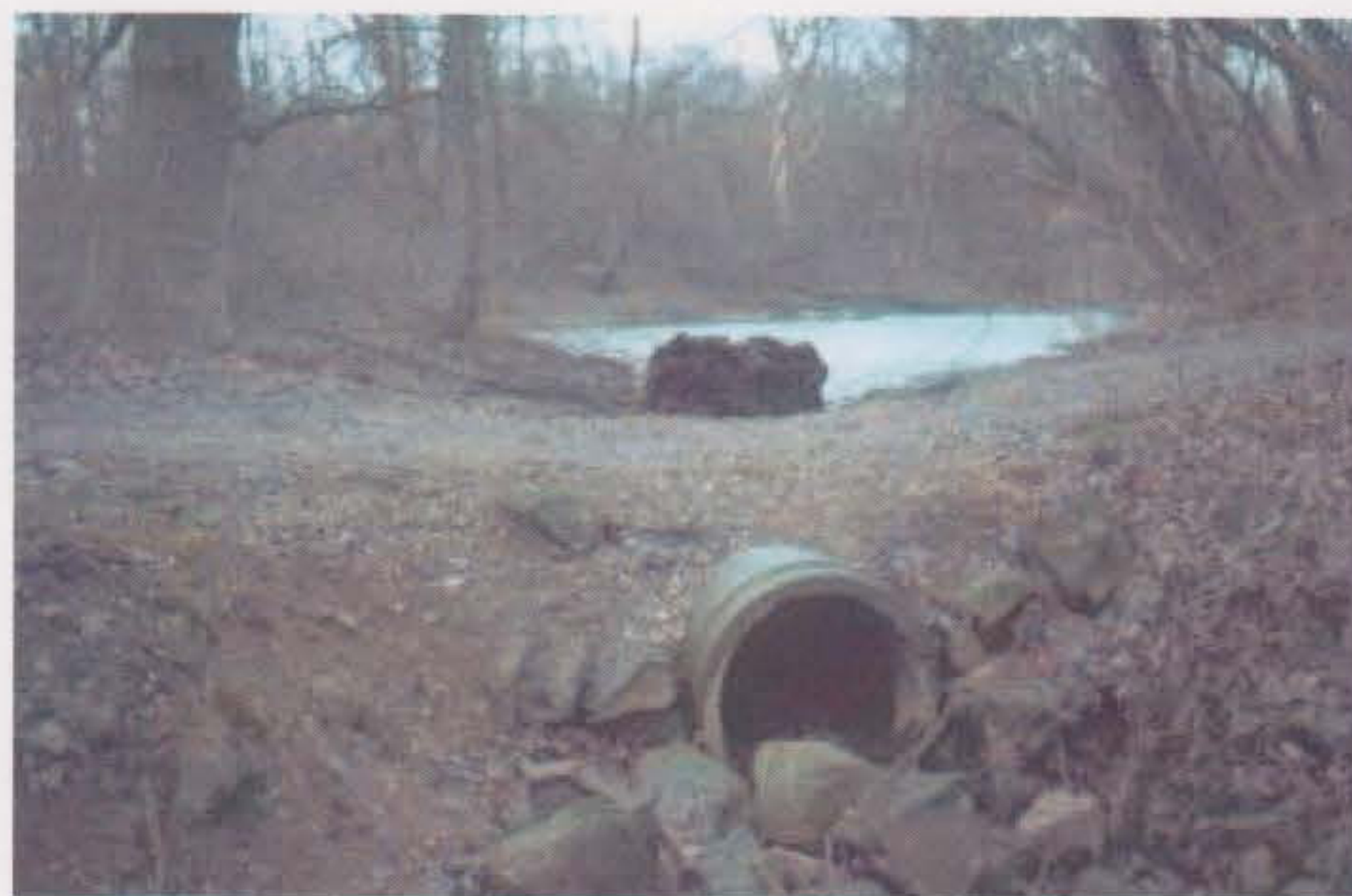
Traverse am „Alten Uferweg“ – wird entfernt und durch einen Fußgängersteg ersetzt
