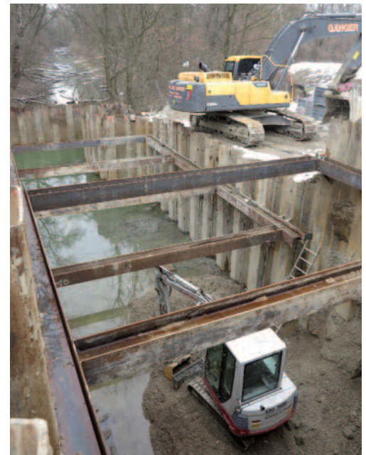
Sielbaustelle Foto NP/Chr. Baumgartner
